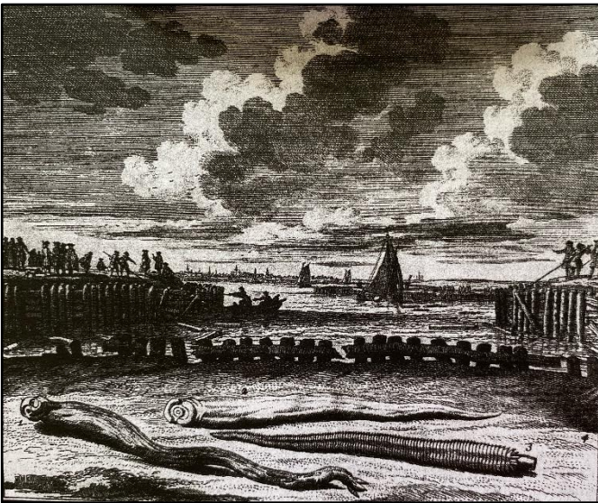
Abb. 5: Abraham Zeeman (1731-1733): Pfahlwürmer, die einen holländischen Stackdeich anfressen, der schon umbricht. Aus Bartels u.a. 2015
