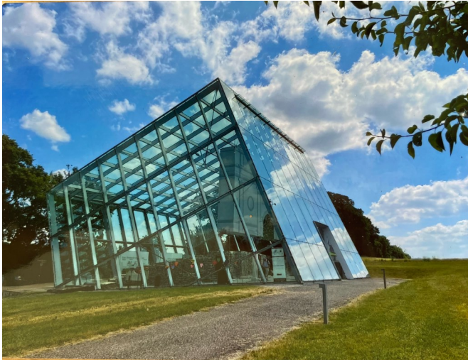
Gläserner Kubus als Schutzbau mit Nachbildung des Ehrentors Dalkingen im Limes-Park Rainau/Ostalbkreis
