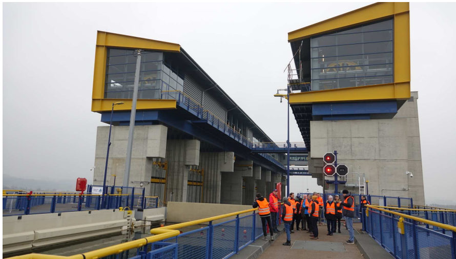
Bild 4: Auf der Plattform der Verbindungsbrücke zum Oberen Vorhafen, die sowohl wesentlich kürzer gestaltet wurde als beim alten Hebewerk und auch mit 12.5m nur die gleiche Durchfahrtbreite hat wie der neue Hebewerkstrog; Nochmal drei Etagen höher oben als architektonischer Blickfang die gläserne Einhausung der beiden Seiltragrollenhallen auf den markanten durchlaufenden Seiltragrollenträgern aus Stahl;
