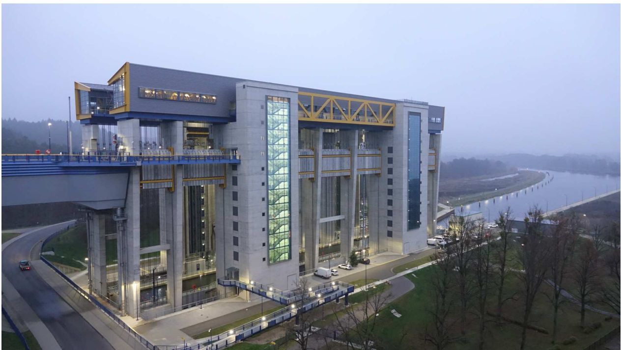
Bild 1: Das Neue Hebewerk Niederfinow Nord, von der Besucherplattform des Alten Hebewerkes aus Richtung Südwesten gesehen; Links die Straße aus Richtung Liepe unter der Verbindungsbrücke vom Oberen Vorhafen zum Hebewerk; Rechts der Untere Vorhafen mit der weiterführenden Havel-Oder-Wasserstraße in Richtung Oderberg und Hohensaaten;
