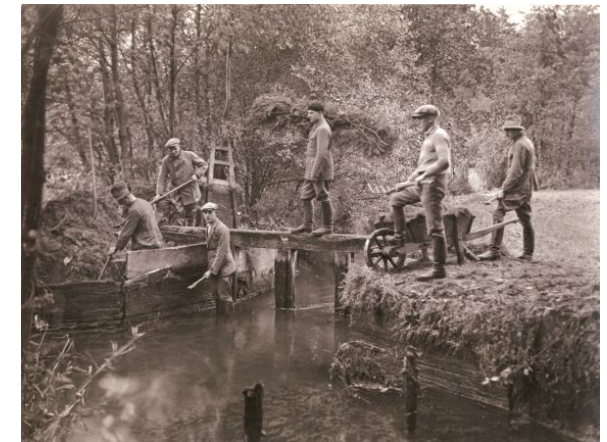
Instandsetzungsarbeiten an einer Stauschleuse in der Hardau durch Schüler der Wiesenbauschule um 1930 (KHG, Sammlung Baumgarten, Museumsdorf Hösseringen)
