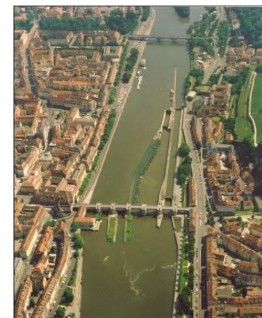
Die Main-Staustufe Würzburg an der Alten Main- Brücke mit dem Wasserkraftwerk Untere Mainmühle (links-1921/22) sowie der Wehranlage und den Schleusen (von 1954), Foto: WSA Schweinfurt
