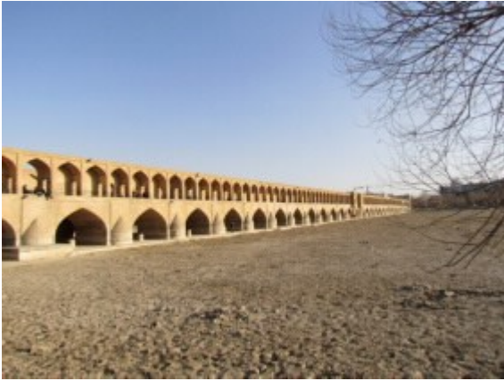
SI-O-SE-POL (die „33-Bogen-Brücke“)
