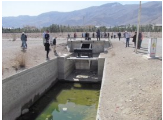
Selbstregulierender Verschluss mit Schwimmer und Gegengewicht für einen Bewässerungskanal
