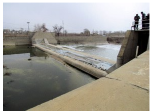
Das moderne Schlauchwehr oberhalb und ....
