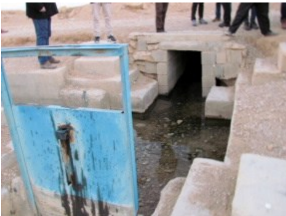
Mundloch eines Qanats westlich von Abadeh
