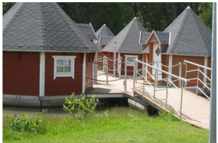
Bild 12: Das „aufgeschwommene“ Hüttendorf beim Hochwasser im Mai 2013
