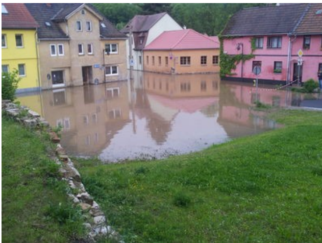
Bild 17: Ilm-Hochwasser in Bad Sulza, Kirchstraße, am 1. Juni 2013
