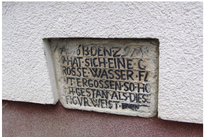
Bild 18: Historische Hochwassermarke in Bad Sulza am Haus Kirchstraße 16
