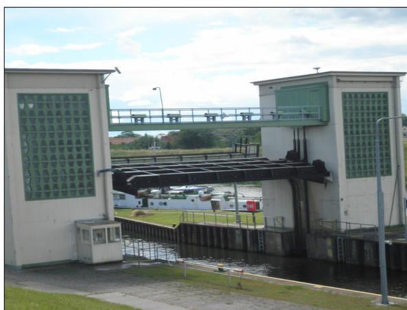
Bild 5: Das Hubschwenktor am Oberhaupt der Westschleuse Hohensaaten
