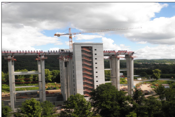
Bild 3: Blick durch das Betonskelett des Neubaus in die Talau
