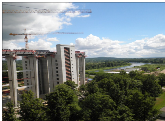
Bild 4: Blick zum halbfertigen Neuen Hebewerk und zum Unterwasser im Juni 2014
