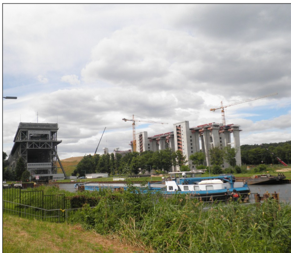
Bild 1: Blick vom Unterwasser auf zwei Giganten der Technik (links Hebewerk Niederfinow von 1934, rechts Neubau im Juni 2014)
